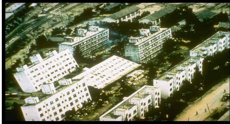
Figure 1. Enfoncement, basculement et renversement des bâtiments lors du séisme de Niigata Japon (1964)
